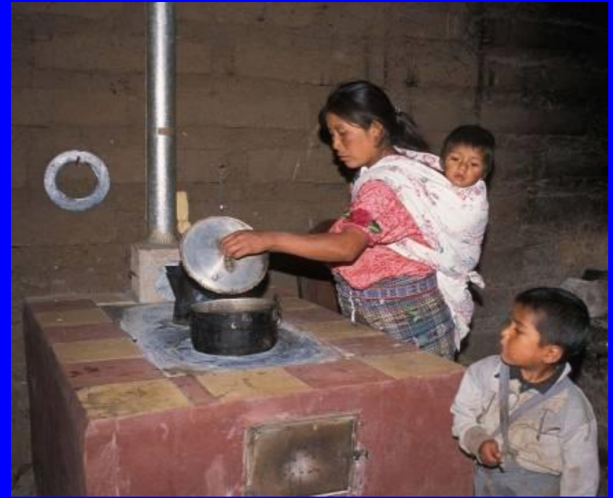
Cocina de leña con chimenea, de construcción local y popular entre los hogares (“Plancha”)
