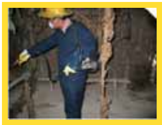
Rociamiento de vivienda
