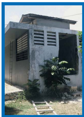
Figura 26: Repositorio construido en el jardín para almacenar las fuentes radiactivas en desuso.
