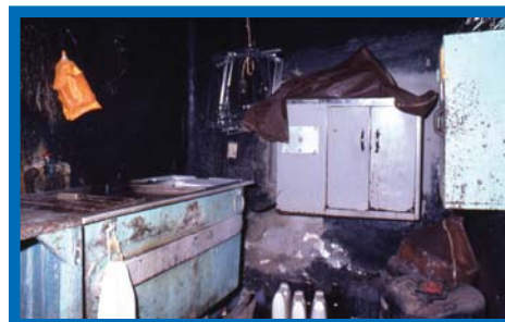
Figura 11: Cuarto oscuro mal mantenido; nótese que la "luz de seguridad" rota se ha sustituido por una bolsa de papel que cubre una bombilla común.
