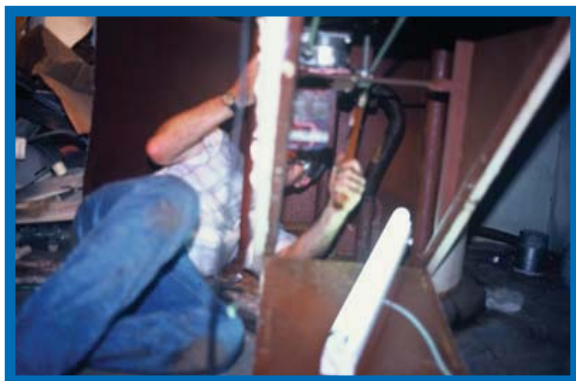
Figura 38: Desmantelando el mecanismo para liberar las gavetas que contenían las fuentes.
