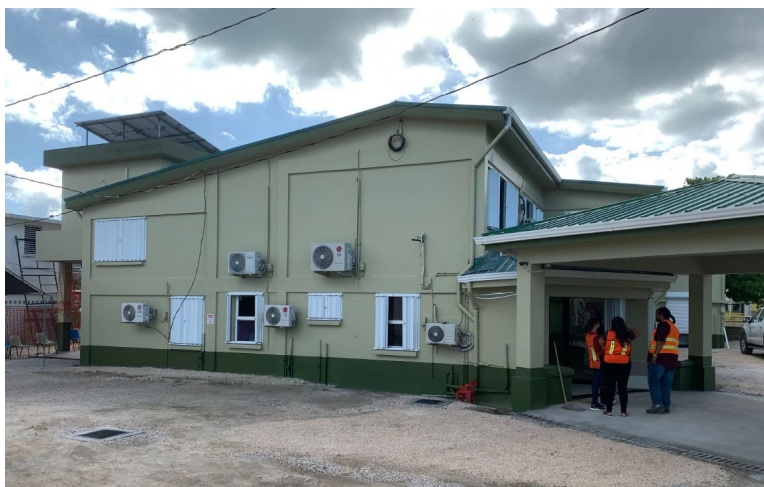
El Policlínico Cleopatra White fue acondicionado con paneles solares fotovoltaicos, unidades de aire acondicionado con tecnología inverter y contraventanas.
