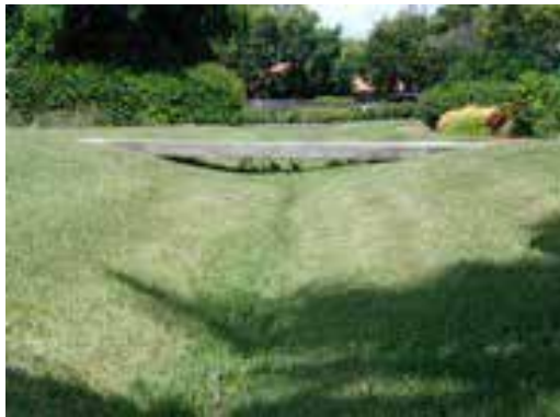
Zanja de césped 6
