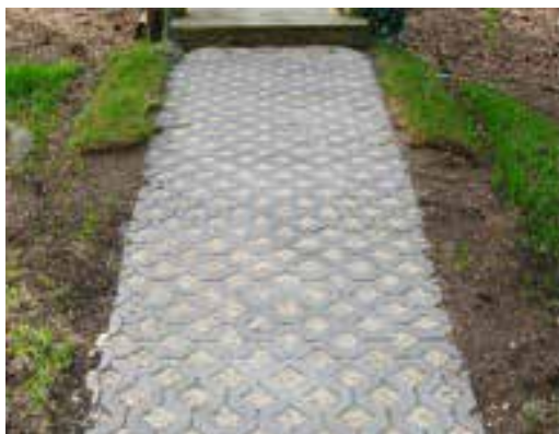
Adoquines impermeables instalados 8
