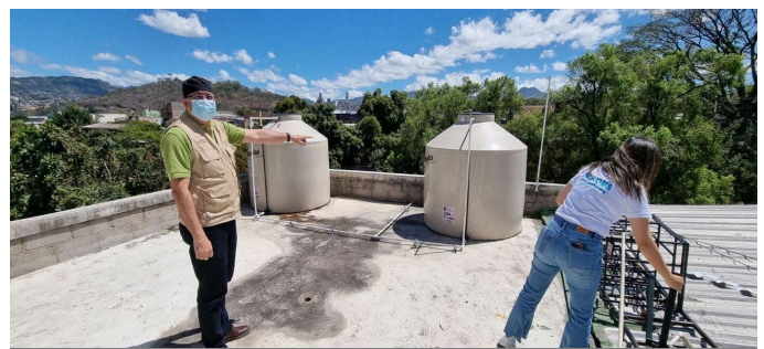
Figura 2: La OPS visita establecimientos de salud reparados gracias a un proyecto de cooperación en Honduras. Fuente: OPS.
