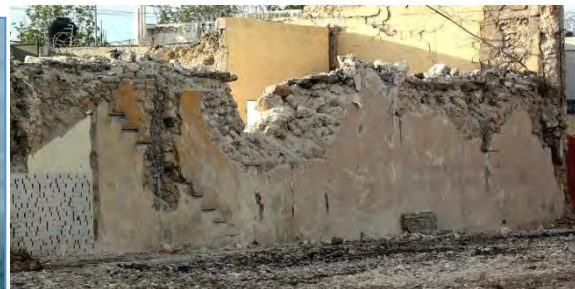
Figure 39 : A gauche, exemple de mur de clôture en maçonnerie de blocs ayant basculé hors plan suite au séisme du 12 janvier 2010. (Source ANCO)
