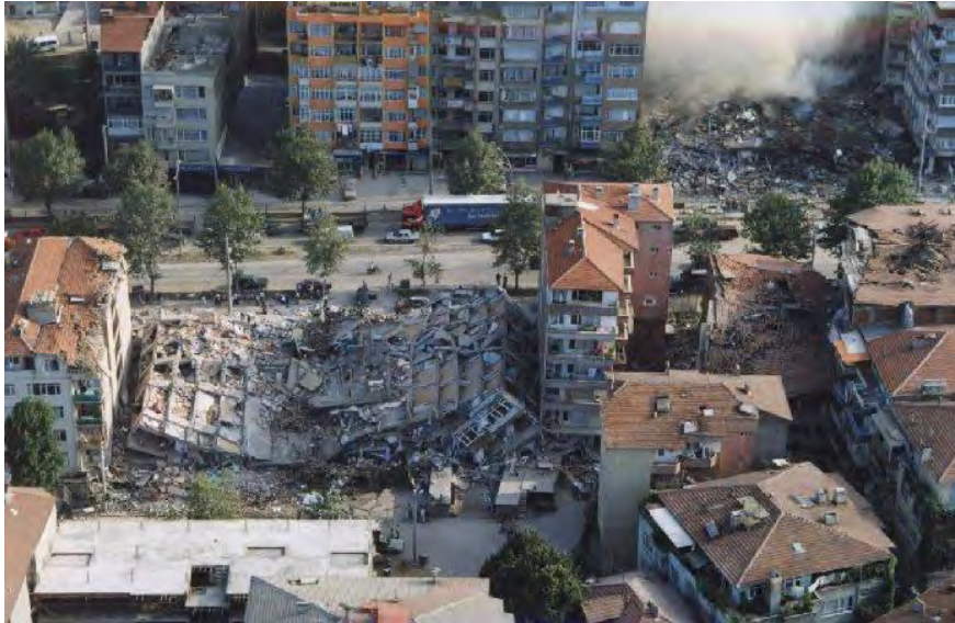
Figure 43 : L'effondrement total des deux immeubles sur cette vue ne s'explique pas par un simple manque de résistance qui doit concerner d'autres immeubles de la zone. Ces deux constructions ont vraisemblablement amplifié les secousses du sol (Séisme d'Izmit, Turquie, 1999). (Source NISEE)
