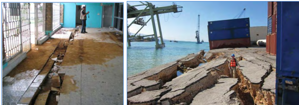
Figure 27 : Observation des dégâts après liquéfaction ; les amas de sable, qui remontent des couches semi-profondes sous l'effet des surpressions d'eau sont caractéristiques du phénomène. (Cliché BRGM)
