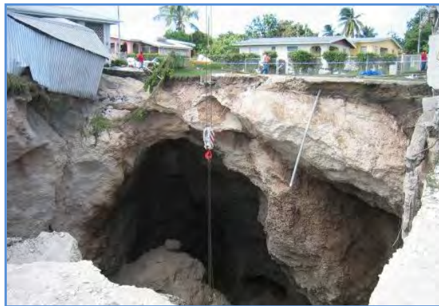
Figure 37 : Effondrement de cavité souterraine calcaire à la Barbade en novembre 2007. (Source Barbados Free Press)
