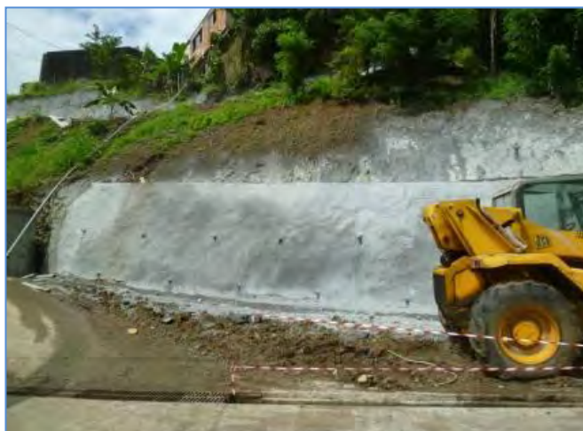
Figure 15 : Barbacanes dans un mur de soutènement. (Source ANCO)
