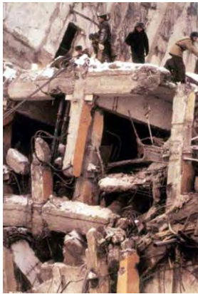
Figure 45 : A gauche, rupture fragile d'une structure de béton armé. Au delà de la limite de résistance, c'est l'effondrement.
