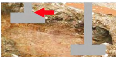
Figure 5 : En zone sismique, il est interdit d'implanter des semelles de fondation à des niveaux différents sans liaison appropriée à la différence de hauteur. (Source ANCO)
