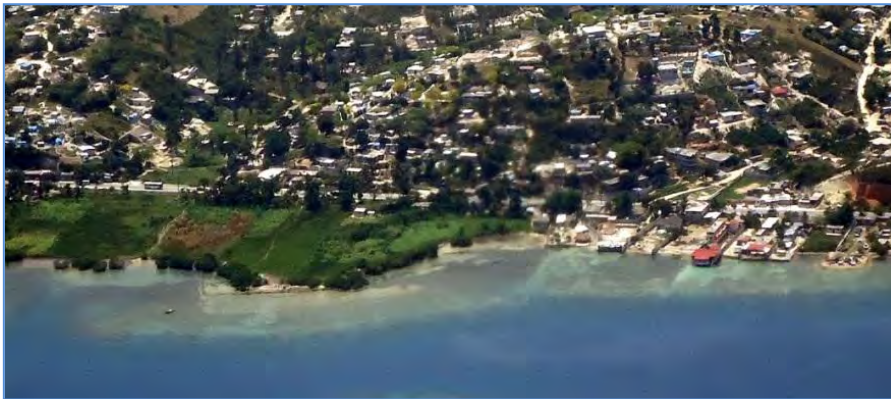
Figure 20 : Vue du littoral vers Léogane, un an et demi après le séisme du 12 janvier 2012. On observe les effets d'une subsidence de quelques décimètres, le littoral s'est affaissé. Des arbres, des anciennes plages et des bâtiments et murs sont partiellement sous le niveau de la mer. (Cliché P. Balandier)
