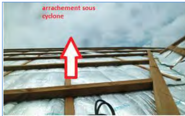
Figure 41 : Les liteaux de couverture doivent être fixés pour résister aux efforts d'arrachement. (Source ANCO)
