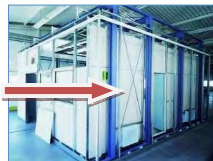
Figure 36 : Exemple de contreventement par câbles d'un box de structure légère non confiné par la structure. (Source GéoHazard)
