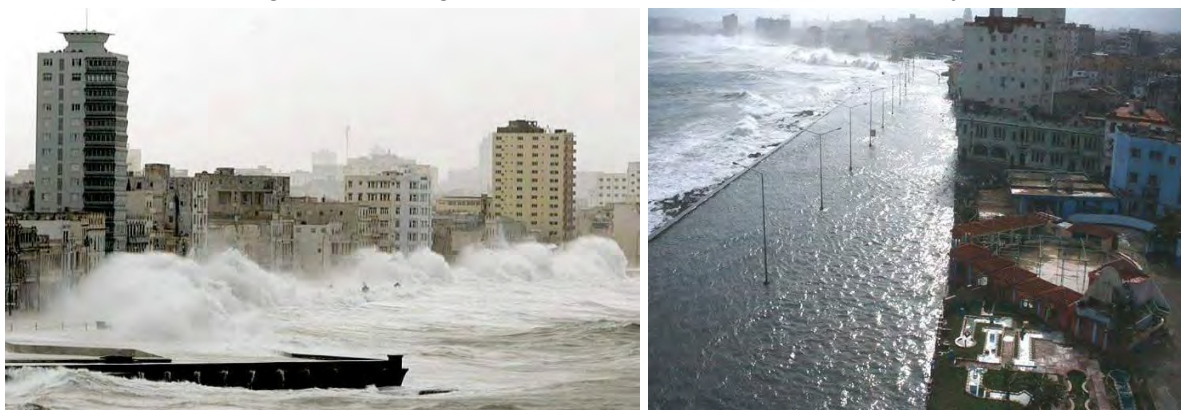
Figure 43 : Vues du Malecon de la Havane pendant et après le passage du cyclone Wilma (2005). Le haut parapet qui protège la ville des tempêtes ordinaires a laissé passer les vagues, puis ralenti le reflux. (Source non identifiée)
