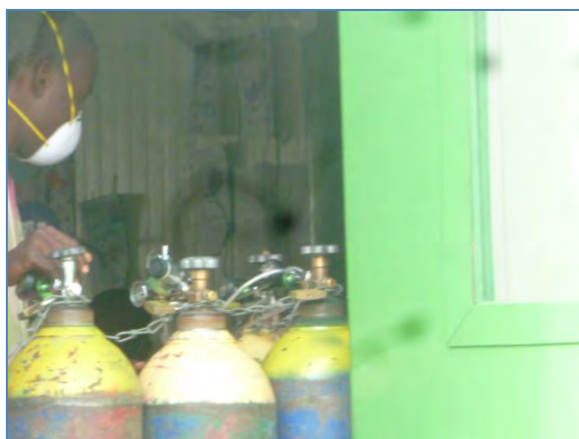
Figure 61 : Exemple de stockage de fluides médicaux non protégé (hôpital en Haïti). (Source ANCO)
