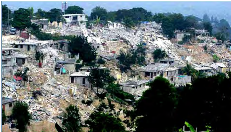
Figure 24 : La concentration de dommages, sols et bâtiments, à proximité d'une crête à Turgeau, lors du séisme du 12 janvier 2010 a sans doute été favorisée par un effet de site. (Document CIAT)
