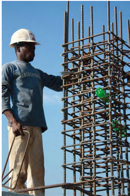
Figure 60 : Exemple, à Pétiön-ville, d'armatures correctement réalisées pour répondre aux exigences de ductilité des poteaux exposés aux efforts sismiques. (Source P. Balandier)
