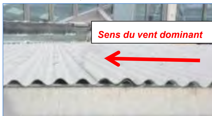
Figure 42 : Recouvrement transversal « sous le vent dominant ». (Source ANCO)
