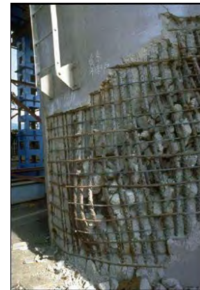
Figure 45 : A gauche, rupture fragile d'une structure de béton armé. Au delà de la limite de résistance, c'est l'effondrement.
