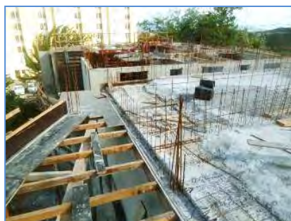
Figure 33 : Arrêt du bétonnage correct sur un mur porteur. (Source ANCO)
