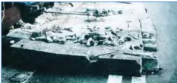
Figure 39 : A gauche, exemple de mur de clôture en maçonnerie de blocs ayant basculé hors plan suite au séisme du 12 janvier 2010. (Source ANCO)
