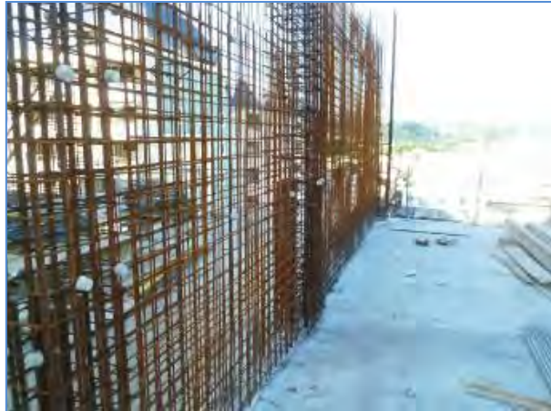
Figure 29 : Des cales d'épaisseur contrôlée doivent être mises en place avant positionnement vertical des coffrages de ce mur. (Source ANCO)
