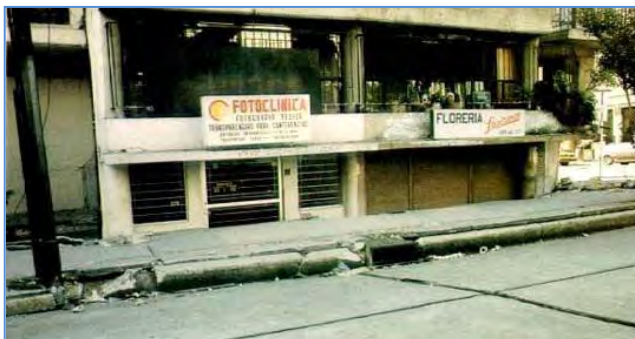
Figure 25 : Enfoncement vertical d'une construction lors du séisme de Mexico 1985. (Document SERVICIO SISMOLOGICO NACIONAL)
