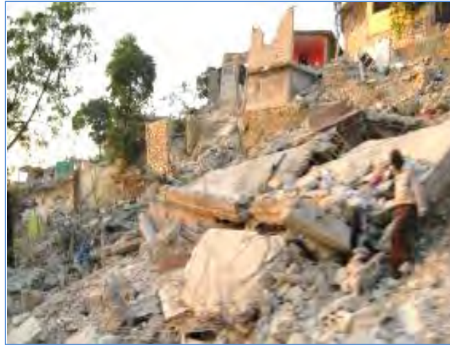
Figure 34 : Eboulements ayant entraîné des constructions le 12 janvier 2010. (Route du Canapé Vert). (Document BRGM)
