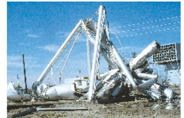
Tanque de agua "resistente a terremotos" destruido después de un terremoto
