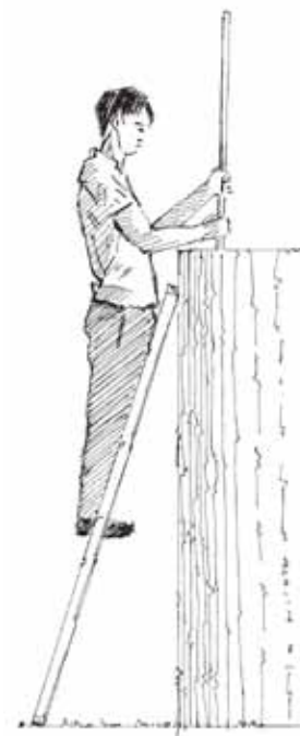
Figura 3 Limpeza interior de tanque usando cepillo
