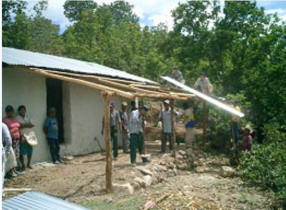
Cambio de Techo (Foto, COTEDIH)
