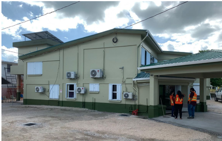
El Policlínico Cleopatra White fue acondicionado con paneles solares fotovoltaicos, unidades de aire acondicionado con tecnología inverter y contraventanas. Fotografía: OPS/OMS Belice.
